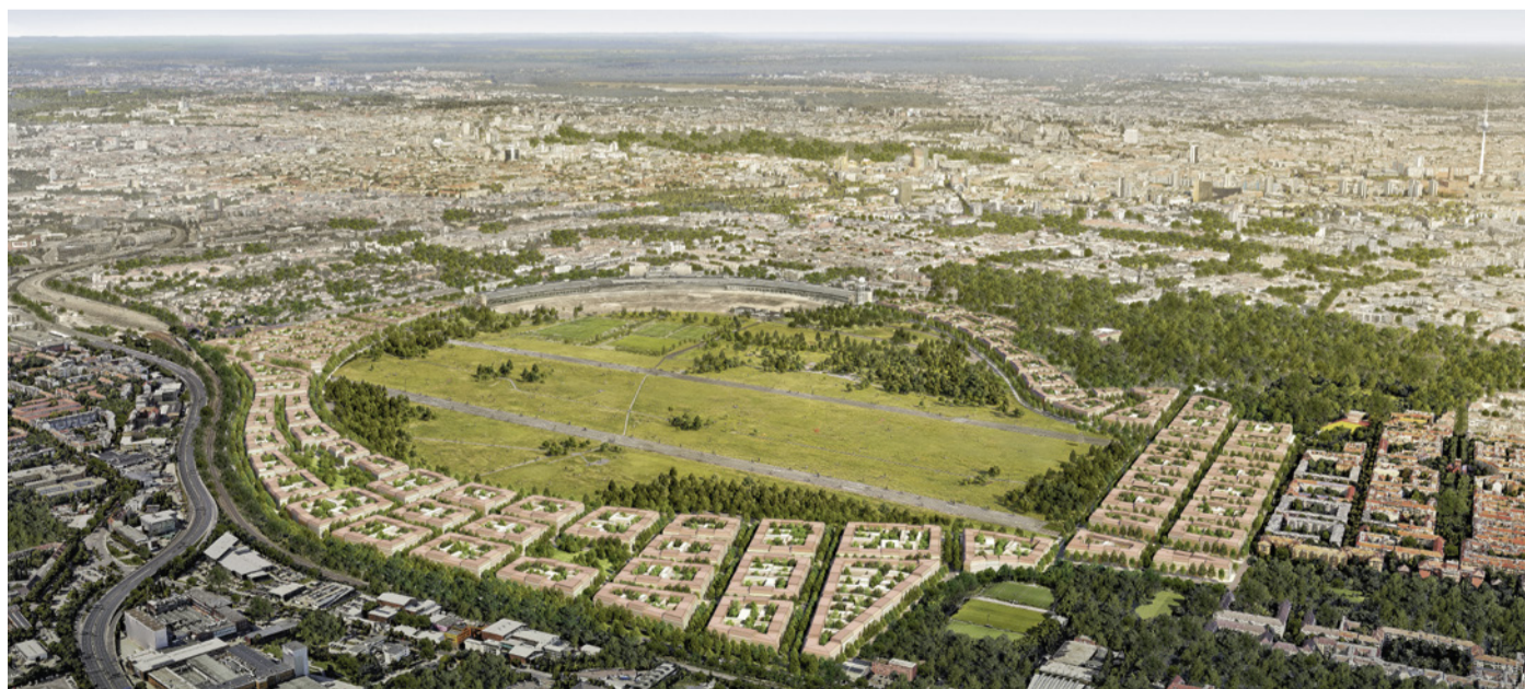
Blick auf das freie Tempelhofer Feld mit Platz für Neubau im Randbereich Bild: Kollhoff/Nöfer/Asstigmatic
